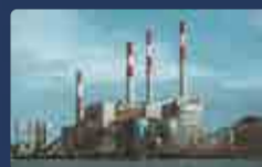
PLANT WATER 工厂用水
